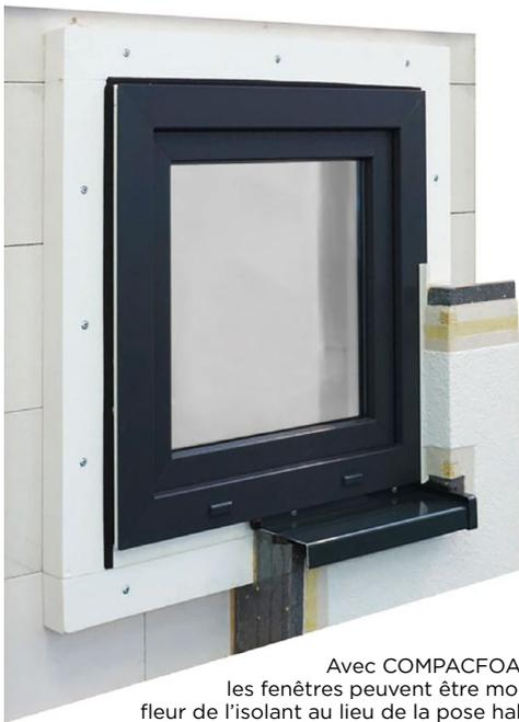
Avec COMPACFOAM ECO les fenêtres peuvent être montées à fleur de l'isolant au lieu de la pose habituelle dans l'ébrasement
