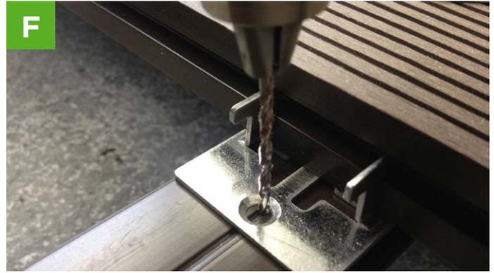
Positionnez la vis dans le trou à l'intérieur du clip le plus près possible de la lame afin d'obtenir une légère traction sur la lame lors du vissage sur la sous-construction. Utilisez exclusivement nos vis de système avec encoche de perçage.
