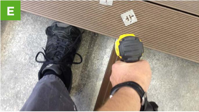
N'utilisez jamais de serre-joints ou d'outils de serrage pour le serrage. Il suffit d'appuyer avec le pied et de pré-percer le clip en conséquence (2,5 mm). Un serrage trop important peut entraîner une déformation de la sous-construction et soulever le sol.
