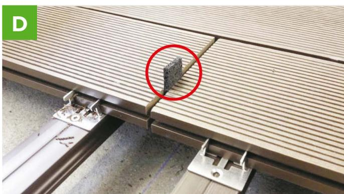
Nous recommandons vivement une «pose décalée à joint de pierre». Poser deux sous-constructions par joint longitudinal (5 + 5 cm). Les lames ne doivent pas dépasser de plus de 5 cm la sous-construction.
