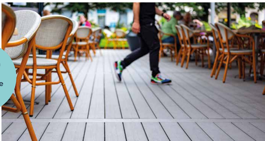
Lame de terrasse Éléance structurée gris Iroise 138 mm, Place Colbert, Rochefort (France)
